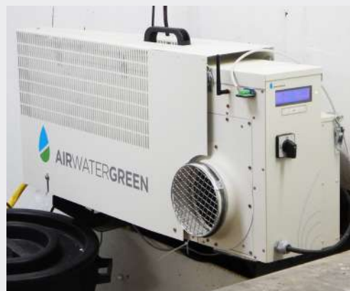
Airwatergreens avfuktare FLEX på plats i en av kamrarna.
