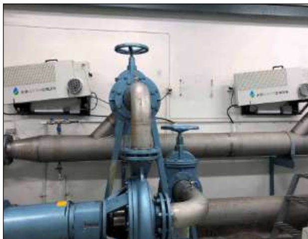
FLEX avfuktare utrustade med dagpunktssensorer för att undvika kondens på kalla för.
